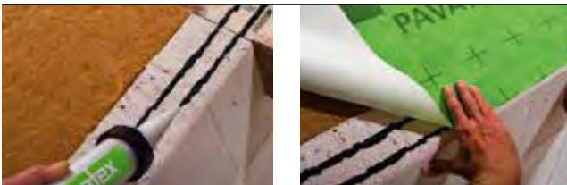
Abb. 18 Verkleben Anschlüsse und Bahnen
