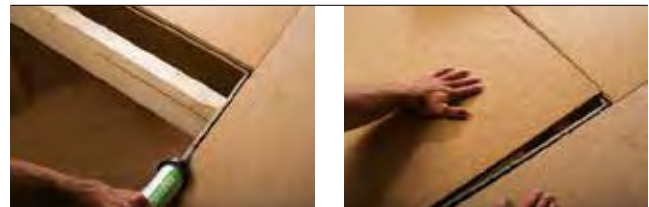
Abb. 19 Verkleben der Plattenstöße
