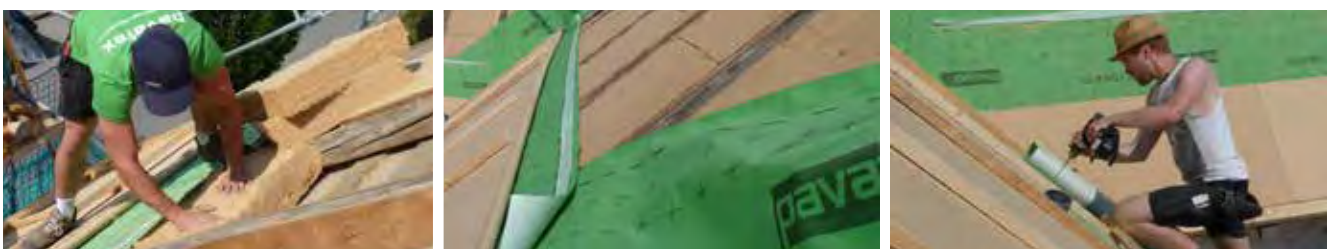
Abb. 17 Dachsanierung von außen ohne Beeinträchtigung des Innenraums.
