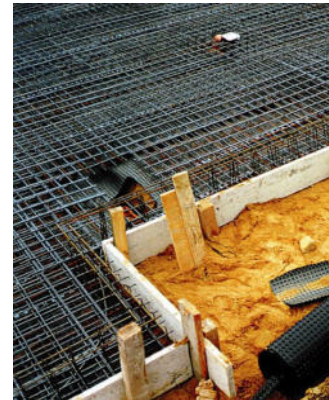
Noppenbahn als Sauberkeitsschicht
