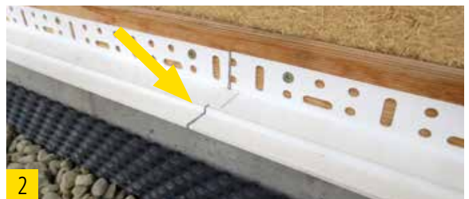
2 Stoßverbinder an den Längsstößen einbauen.
