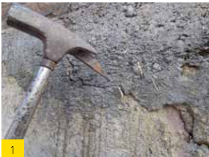
1 Lose Putzschichten entfernen.
