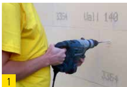
Vorbohren mit Schlagbohrmaschine.
