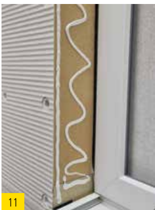
best wood FDM WALL seitlich auftragen und ein Stück best wood Fugendichtband an die Fensterbank anbringen anschließend Fensterbank an die Wand schieben.
