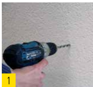
1 Verputzte Holzfaser-Dämmstoffplatte mit 8 mm-Holzbohrer vorbohren.
