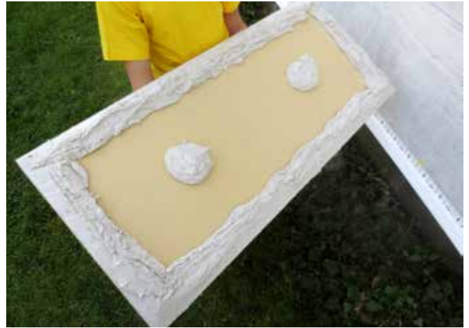
Auftrag Punkt-Wulst-Verfahren.
