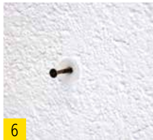
6 Mit 4–5 mm Schraube Anbauteil befestigen.
