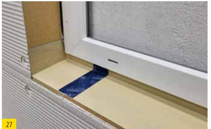
27 TESCON VANA gut festdrücken - gleiche Vorgehensweise an beiden Stößen.
