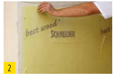
2 best wood Armierungsgewebe einlegen.
