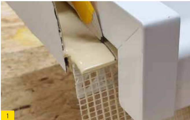
1 Fensterbanklänge auf rechtem und linkem Dichtkeil anzeichnen.
