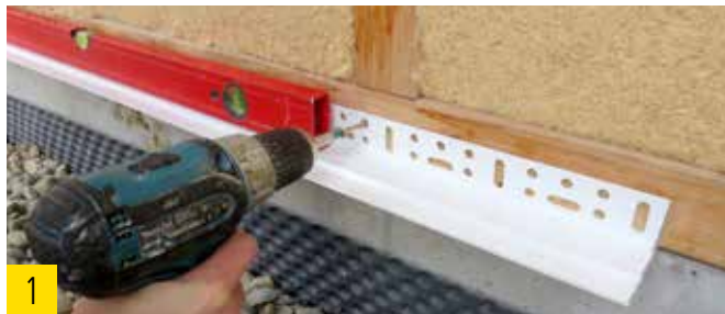
1 Sockelprofil waagrecht ausrichten und befestigen.
