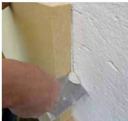
Seitlich austretenden Kleber entfernen.
