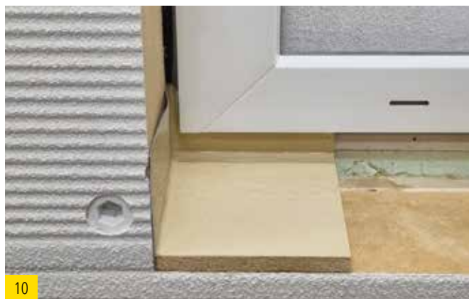
Der 5 mm Überstand der Lippe soll ein U zwischen der Fensterkante und der Holzfaserplatte bilden.
