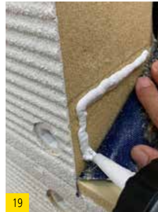
Stirnseitig best wood FDM WALL aufbringen. Mit Hilfe eines Keils anschließend die Dichtecke zwischen der Fensterkante und der Holzfaserplatte gut eindrücken.
