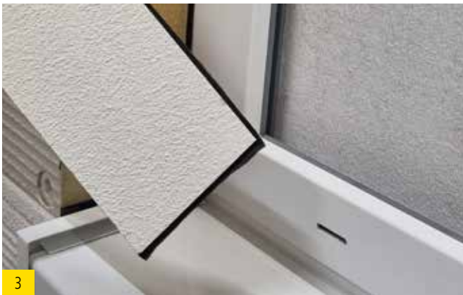
3 Laibungsplatte auf Gefälle der Fensterbank schneiden und an der kurzen und langen Seite best wood Fugendichtband Typ 12/3-7 anbringen.
