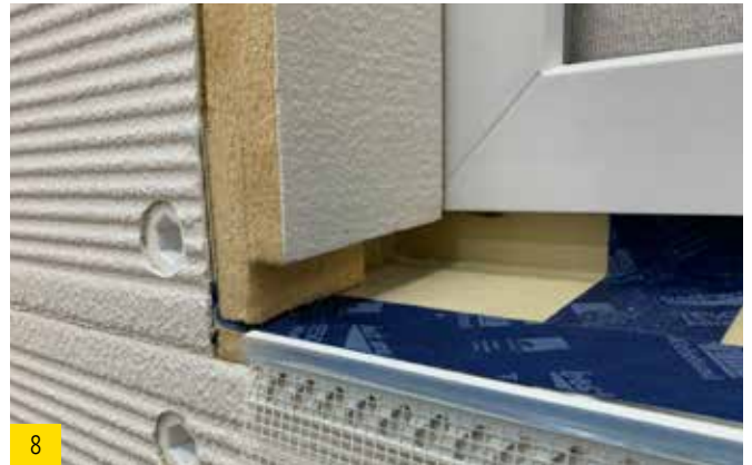
40 mm Laibungsplatte kurz anstellen und prüfen.
