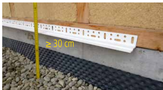
Spritzwasserzone \geq 30 cm ohne zusätzliche Maßnahme.
