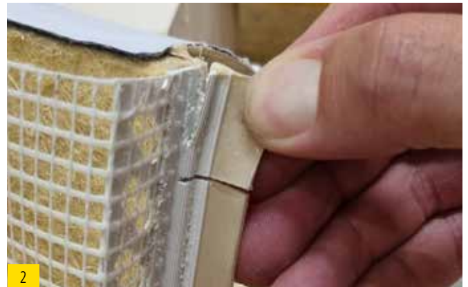
2 Putzabschlussprofil inkl. Gewebesteg auf angezeichnete Länge kürzen.
