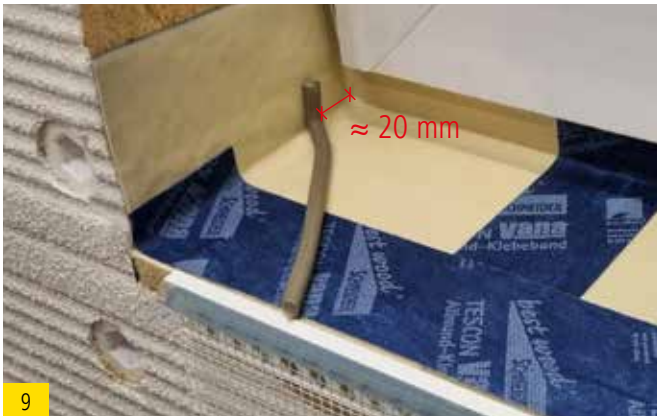
Dichtschnur unter 45° im Abstand von ca. 20 mm ab Hinterkante Aufkantung 2. Dichtebene bis an das Putzabschlußprofil Fensterbank legen.
