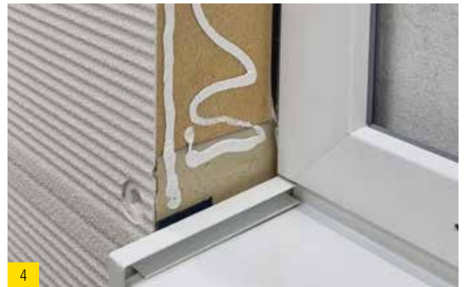
4 best wood FDM WALL seitlich auftragen.
