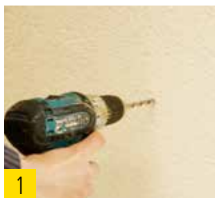
1 Unverputzte Holzfaser-Dämmstoffplatte mit 8 mm-Holzbohrer vorbohren.
