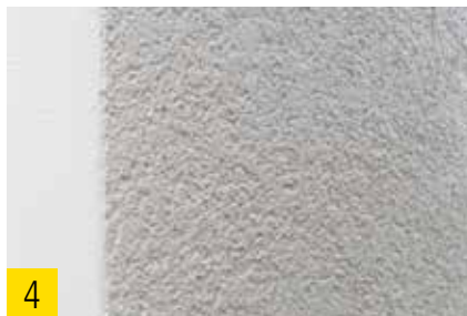
Fertig strukturierte Putzfläche.
