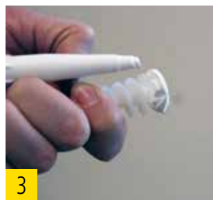
3 best wood FDM WALL zur Abdichtung verwenden.
