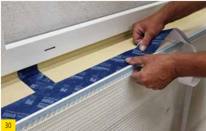
30 best wood Putzabschlussprofil Fensterbank mit TESCON VANA auf der Dichtebene ankleben.
