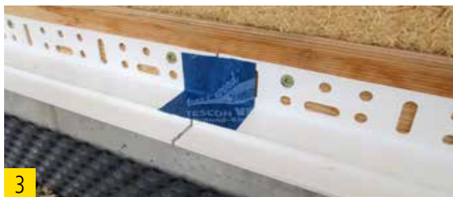
3 Stoß mit Gewebeklebeband abkleben.
