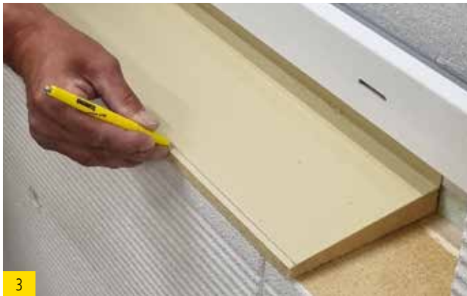
3 Dichtkeil mit entsprechender Tiefe anzeichnen.
