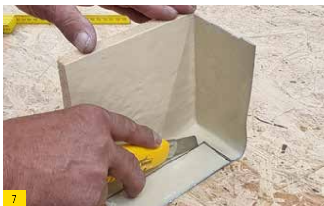
Die Dichtecken an die Fensterecken anpassen.
