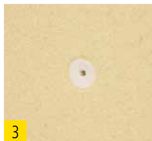
3 Schraubdübel oberflächenbündig montieren.
