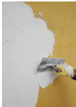
Klebe- und Armierungsmörtel (UP) aufbringen.
