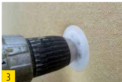
Dübel oberflächenbündig anziehen.
