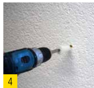
4 Spiraldübel mit TORX T40 oberflächenbündig mit verputzter Holzfaser-Dämmstoffplatte eindrehen.
