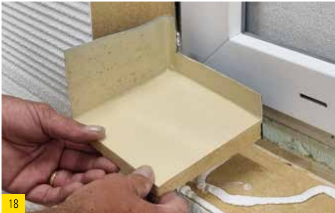
Die Dichtecken in beide Ecken positionieren
