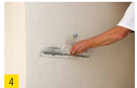
4 best wood Armierungsgewebe eingespachtelt.
