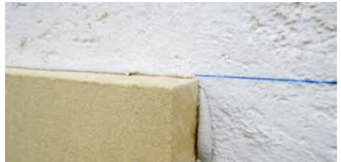
WALL 140 an waagerechter Schlagschnur ausrichten.
