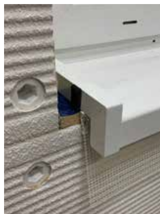
best wood FDM WALL seitlich auftragen und ein Stück best wood Fugendichtband an die Fensterbank anbringen anschließend Fensterbank an die Wand schieben.
