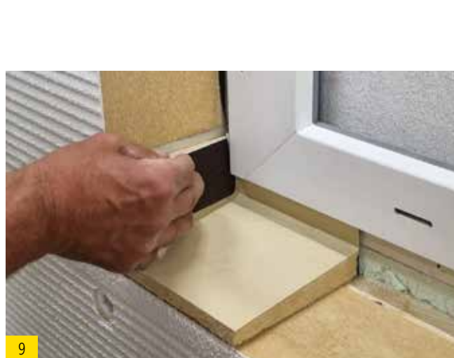
Beide Eckteile einlegen und mit einem Hilfsmittel (z. B. Holzkeil) sauber in die Ecke der Fensterbank eindrücken.
