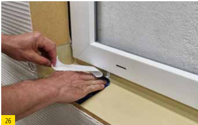
26 Denselben Stoß mit einem Streifen TESCON VANA überkleben.
