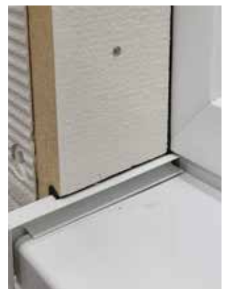
Bei der Laibungsplatte 40 mm an der kurzen und langen Seite best wood Fugendichtband anbringen. Anpassen und fest andrücken. Laibungsplatte verschrauben.
