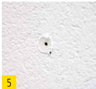
5 Überschüssige FDM WALL zwischen Putz und Spiraldübel entfernen.
