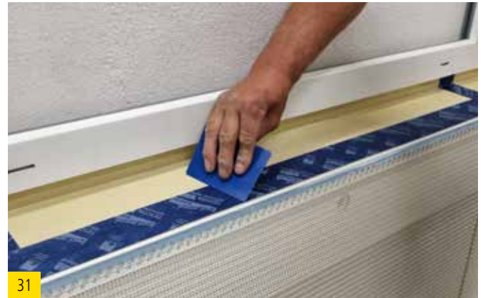
31 Klebeband mit einer Rakel glattstreichen.
