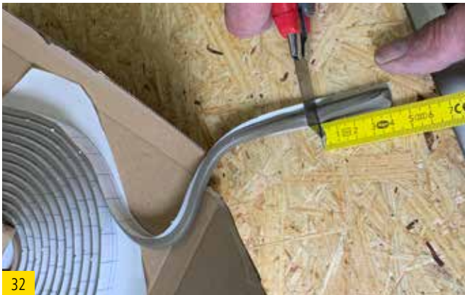
32 4 cm der Dichtschnur abschneiden.
