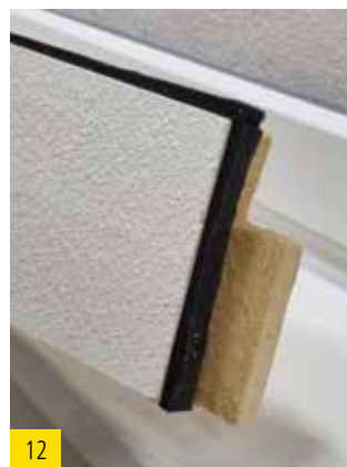
Bei der Laibungsplatte 40 mm an der kurzen und langen Seite best wood Fugendichtband anbringen. Anpassen und fest andrücken. Laibungsplatte verschrauben.
