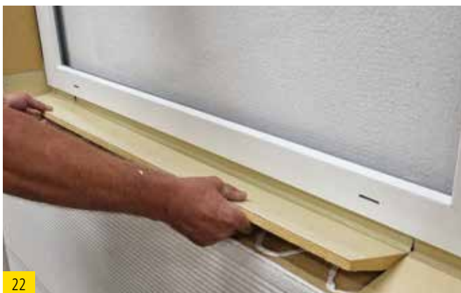
Den Dichtkeil zwischen den Ecken passgenau eindrücken
