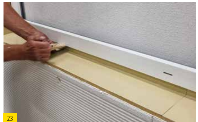
Unterhalb des Fensterrahmens ebenfalls mit einem Hilfsmittel (bspw. Holzkeil) den Klebestreifen fest andrücken
