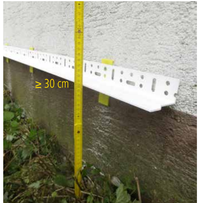
Spritzwasserzone \geq 30 cm ohne zusätzliche Maßnahme.
