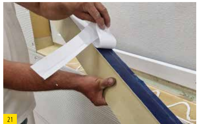
Das Klebeband des bereits zugesägten Dichtkeils abziehen
