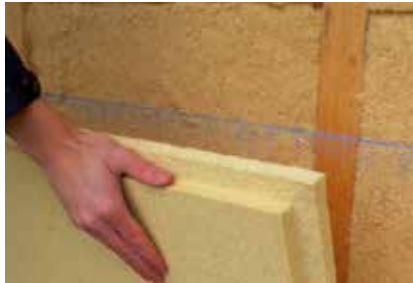
Erste Plattenreihe an waagrechter Schlagschnur ausrichten.
