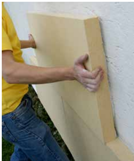
WALL 140 mit schiebenden Bewegungen anbringen.
