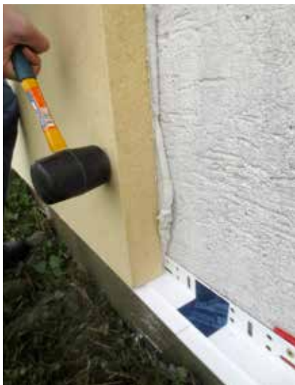
WALL 140 vollflächig auf Sockelschiene aufstellen.
