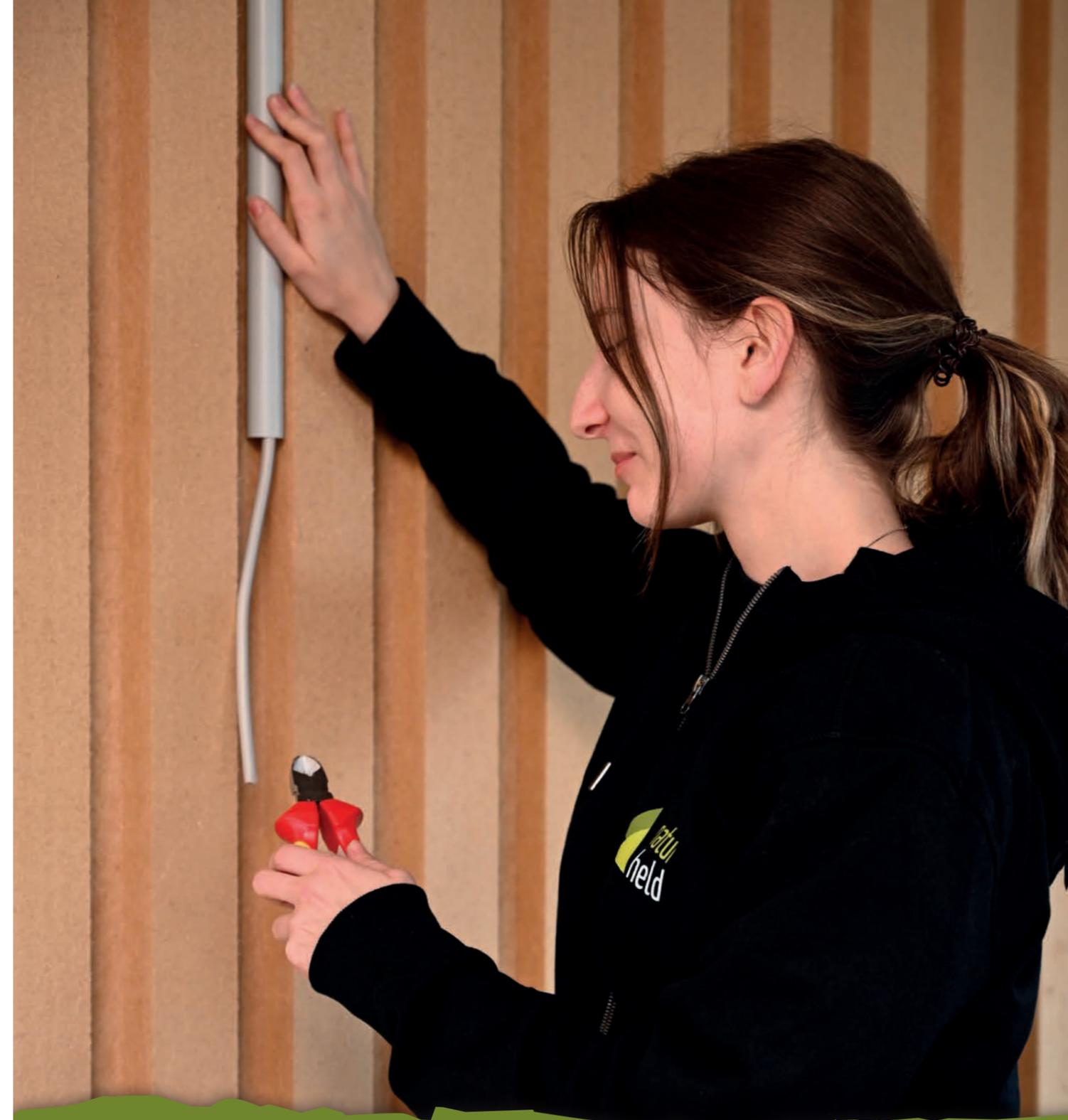
Mit der naturheld 140-Install können Verarbeiter die Montagezeit auf der Baustelle verkürzen. Die feste Holzfaserdämmplatte kommt ab Werk mit vorgefrästen Kanälen für die Installationen.
