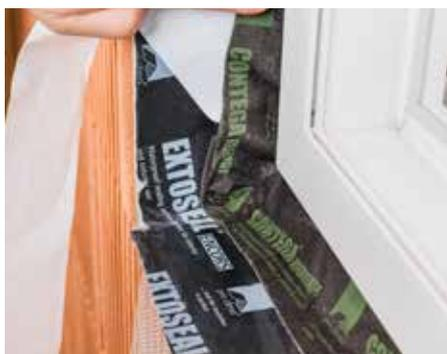
In Ecken luft- bzw. schlagregendicht verkleben.
