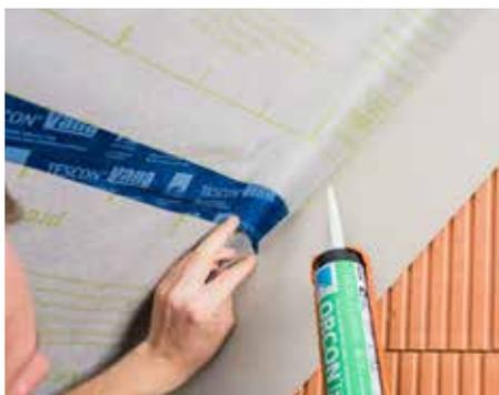
Anschlusskleber für Luftdichtungsbahnen innen,
