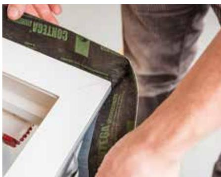
Eckschlaufe herstellen (Länge: 1,5 x Fugenbreite).
