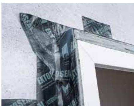
Anschluss von Fenstern im Mauerwerks- und Betonbau.
