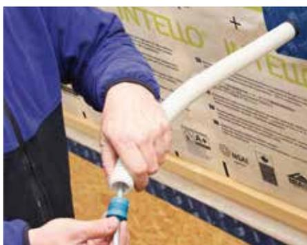
STOPPA dichtet Kabel in Leerrohren ab.
