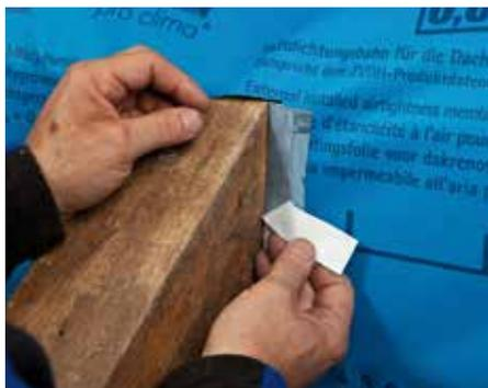
Trennfolie ablösen: Bahn und Sparren luftdicht verkleben.
