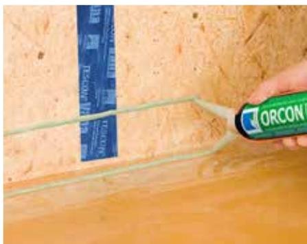
... und Bodenanschlüsse von Holzwerkstoffplatten,
