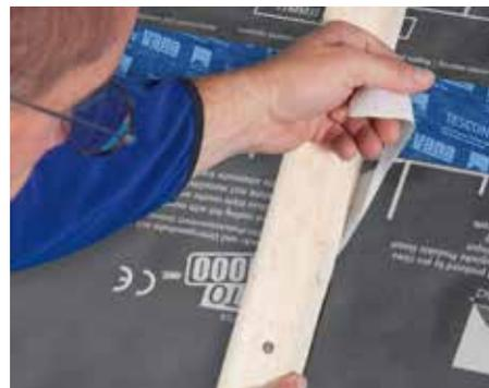
Trennpapier Zug um Zug entfernen.
