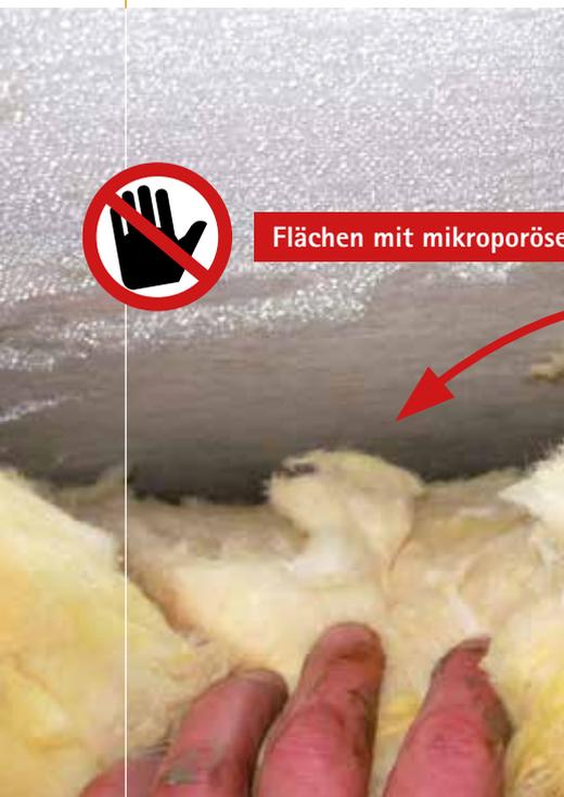
Flächen mit mikroporöser Bahn: Feuchtigkeit
