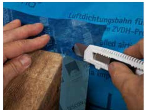
Bahn mit TESCO VANA luftdicht am Sparren anschließen.
