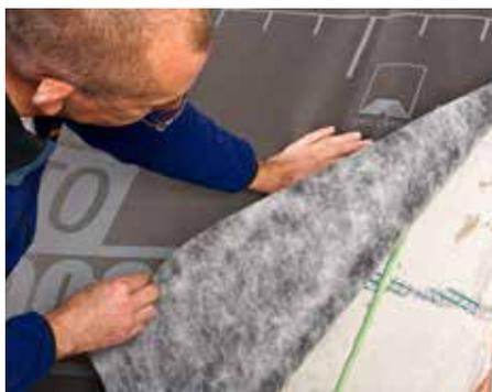
... Winddichtungsbahnen außen,
